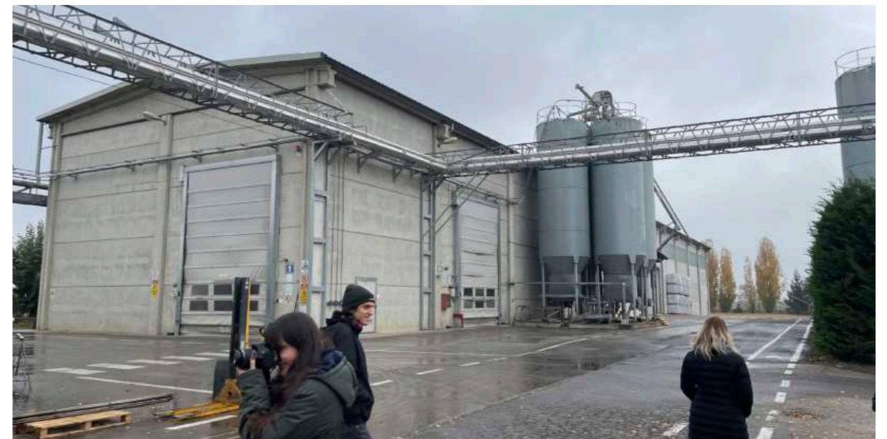
Figura 17. Dettaglio stabilimento. Fonte: foto dell'autore
