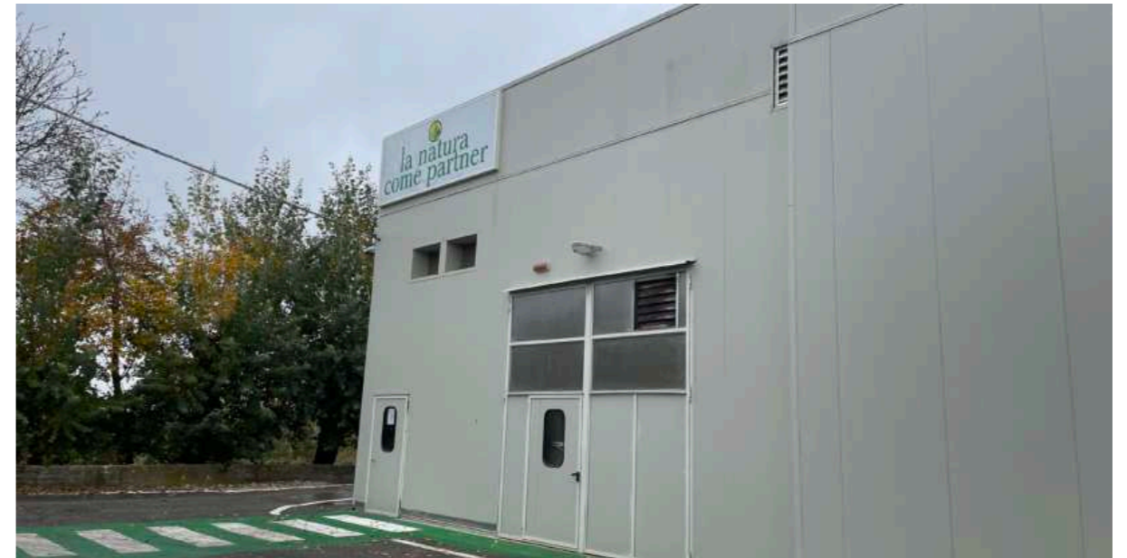
Figura 16. Dettaglio stabilimento. Fonte: foto dell'autore
